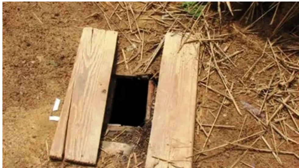
Gambar 3. 1. Contoh gambar jamban sehat sederhana
