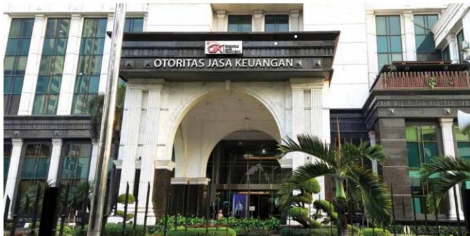
Gambar 1.1 Gedung Otoritas Jasa Keuangan
